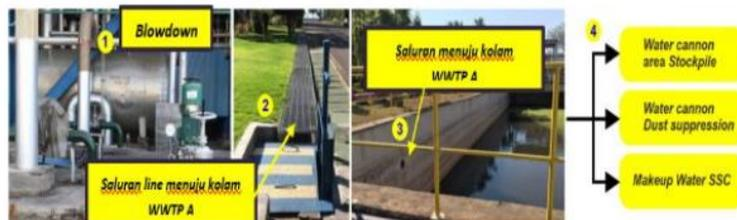
Gambar . Inovasi Penambahan line water transfer menuju kolam WWTP A, sebagai sarana pemanfaatan kembali air limbah unit pembangkit.
