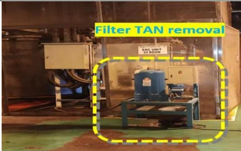
Gambar . Lokasi Pemasangan TAN Removal, Di sebelah EHC Tank
