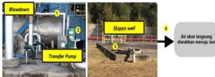
Gambar . Air dari blowdown tank akan dipompa langsung menuju shipon well lalu kemudian dilarung ke laut atau Outfall (sesuai batas baku mutu air).
